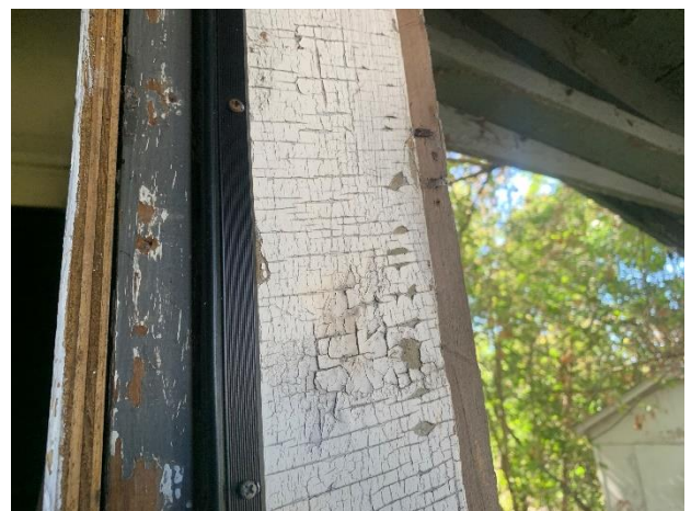
Door Stop Back Entry Side C Interior/Exterior Door
