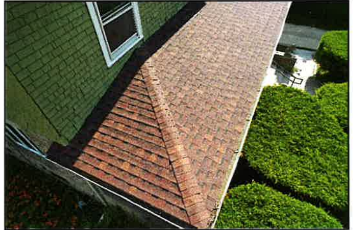
17. Asphalt shingles
