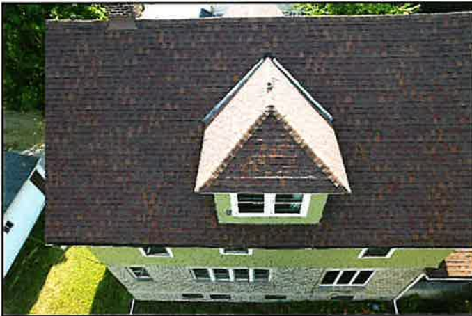
14. Asphalt shingles
