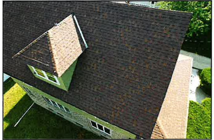
15. Asphalt shingles
