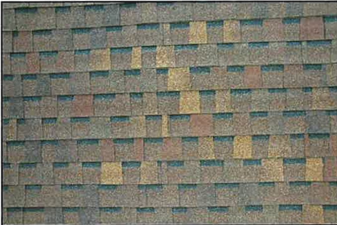
16. Asphalt shingles
