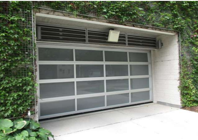
Louvers above garage door
