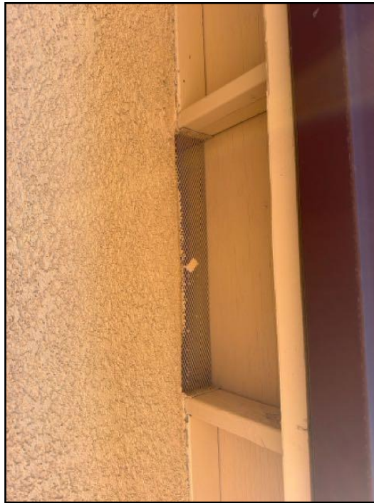
38. Soffit vent
