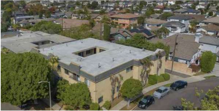
B 7605 W Manchester Ave Los Angeles, CA 90293
