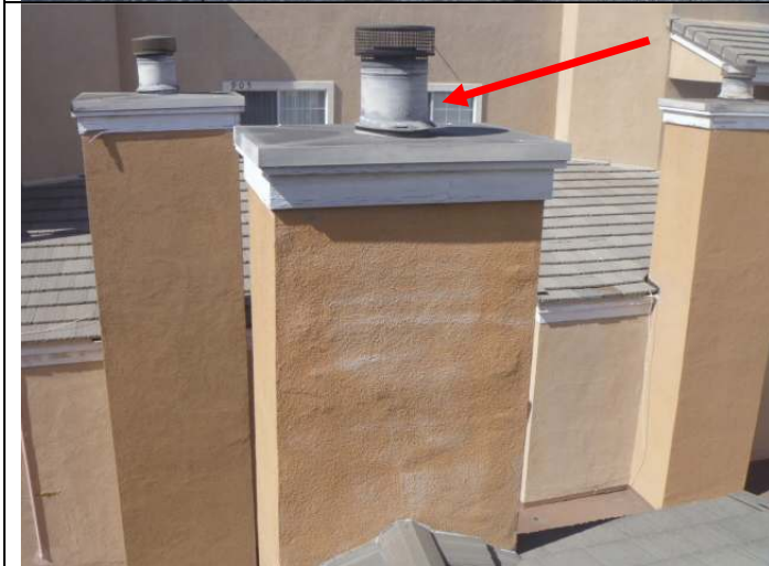
Chimney upper exterior.
