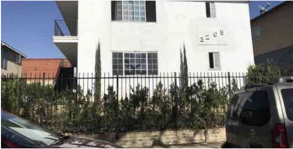
D 3205 Bartdon Ave Inglewood, CA 90303
